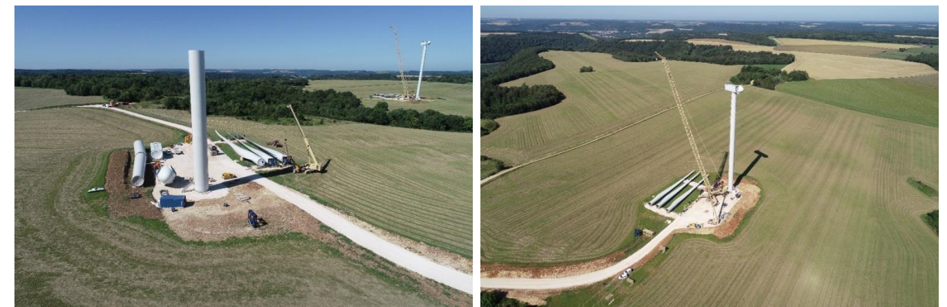
Photo 2 : Exemple de montage des éoliennes – Parc éolien de Piroy (Source : CALYCE DEVELOPPEMENT)
