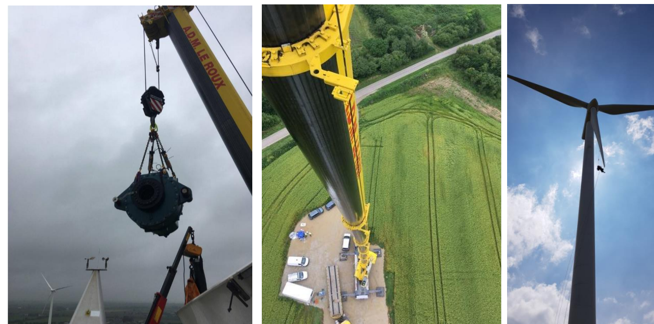
Photo 3 : Remplacement d'un multiplicateur – Parc éolien de Ploudalmézeau (Source : ROMANDE ENERGIE)
